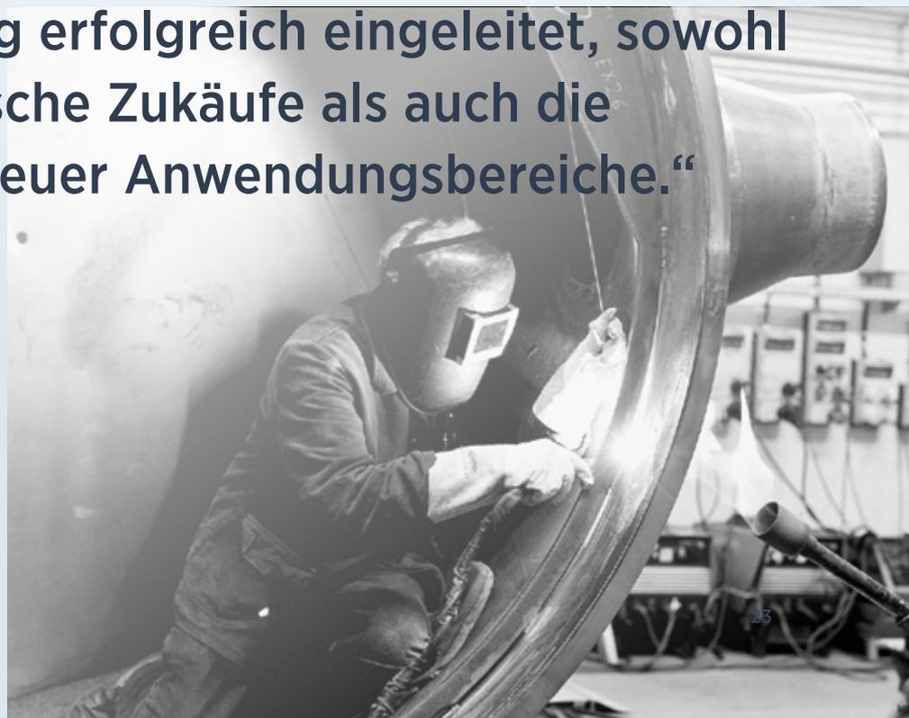
Schweißarbeiten an einem Speisewasservorwärmer für ein Kernkraftwerk
