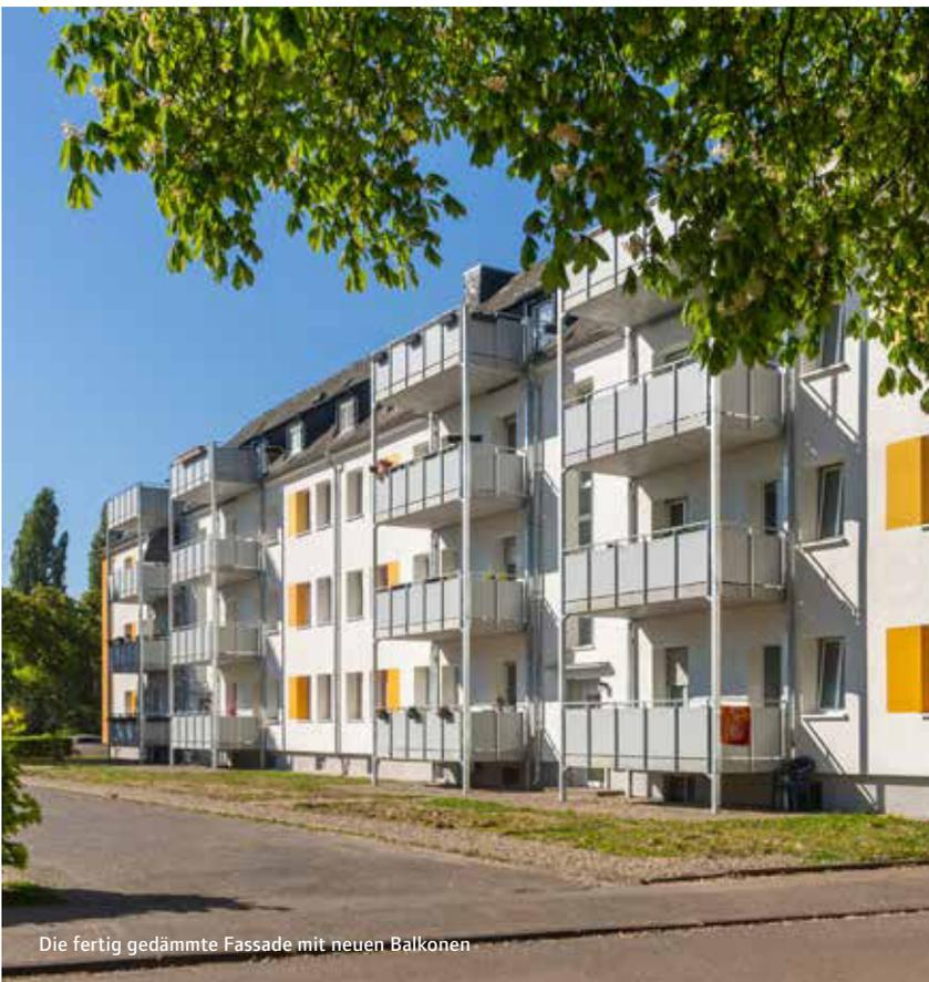
Die fertig gedämmte Fassade mit neuen Balkonen
